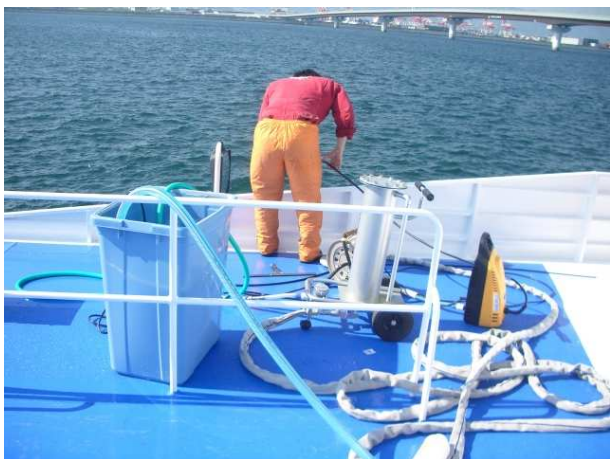
ウォーターコート施工
