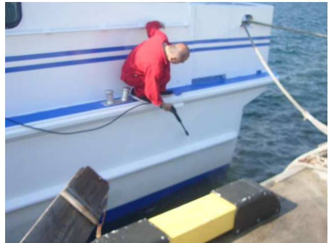
ウォーターコート施工
