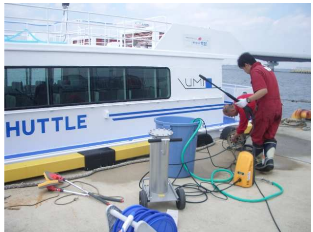
ポリ容器にアルカリ洗剤を注入後高圧洗浄機接続
